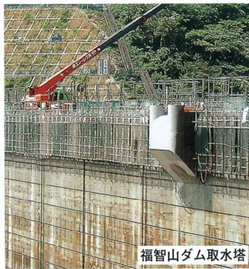
河川改修 (HEP工法エレメント二次覆工)
