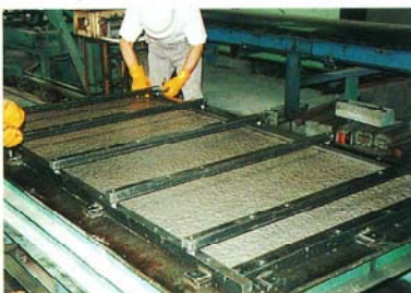
① コンクリート板の製作
