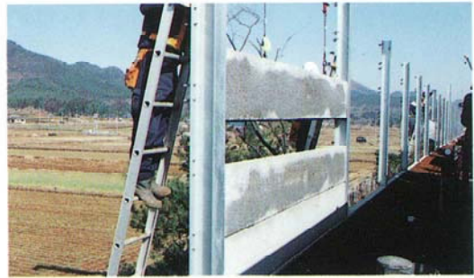
②支柱に取付け
