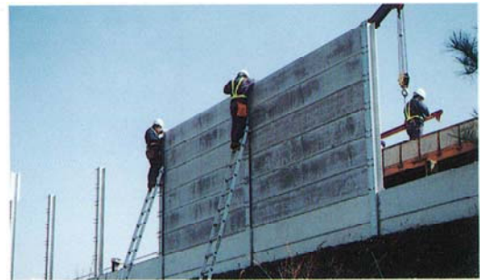
④1区間6段積みで完了
